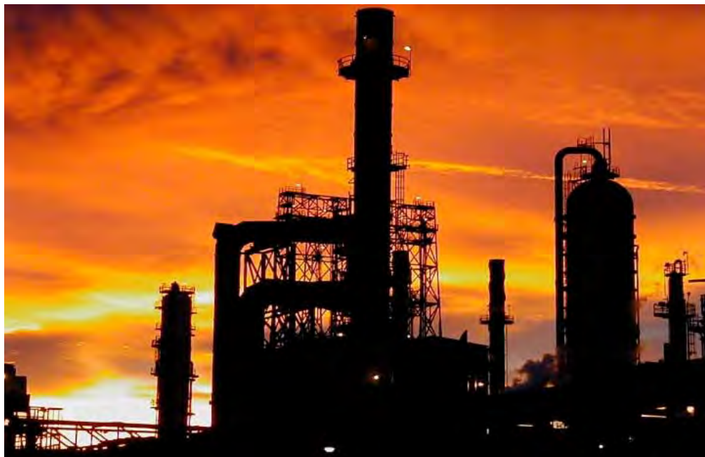
Fig. 3. Fischer Tropsch Plant
