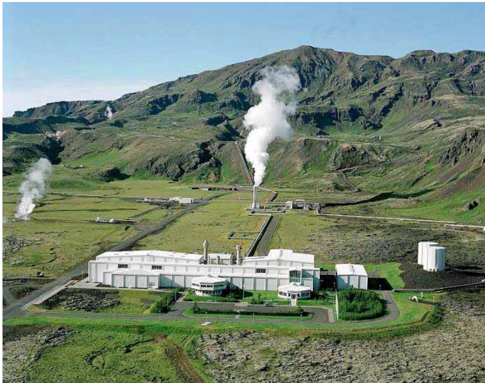
Fig. 3. Nesjavellir power plant.
