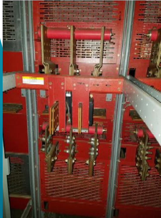
600V Drawout Switchgear
