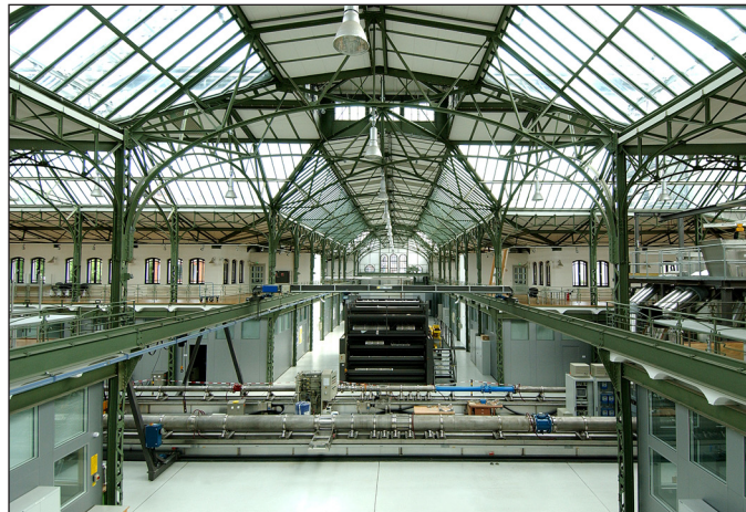
Innenansicht Hermann von Helmholtz-Bau
