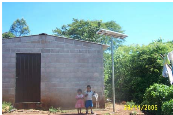
Proyecto de Electrificación Rural en la Comunidad Las Flores en Caluco
