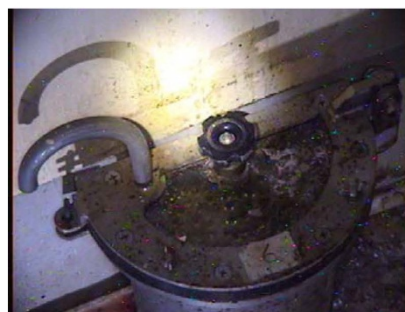
2. 機器ファンネル
