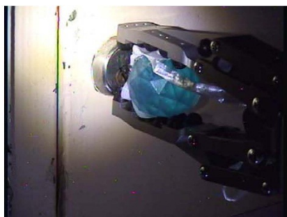
1. TIP室扉鍵開け作業
