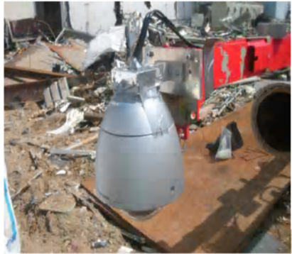
ブーム先端へのカメラ等の設置
