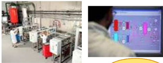
Plate-forme "systèmes thermiques"
